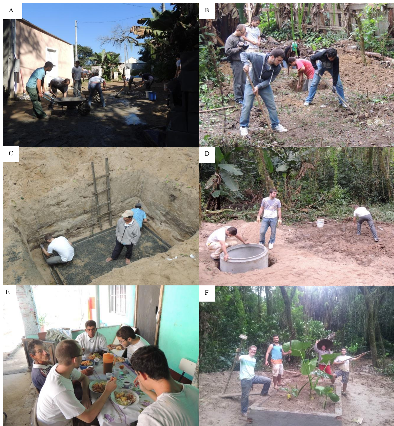
Figura 5. Membros da equipe D-lab ITA trabalhando em parceria com os membros da comunidade durante a implementação das fossas.
