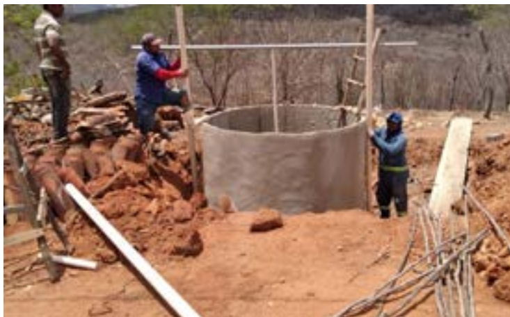
Figura 7 – Construção do Biodigestor rural
