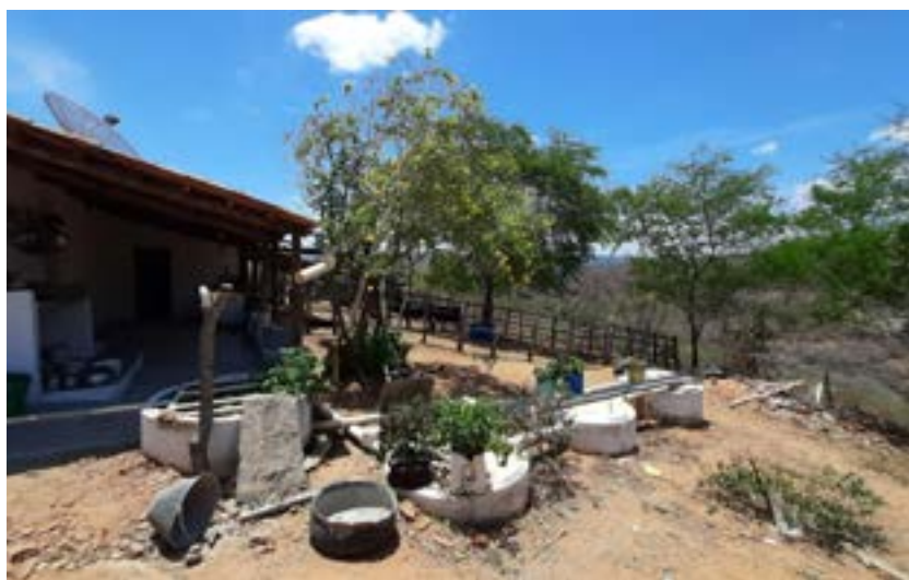
Figura 1 – Sistema fossa biodigestora + Sistema bioágua
